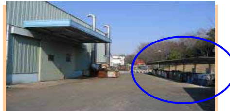
下館工場の分別ステーション(2007年2月設置)
