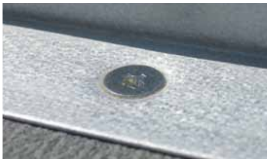
▲鉄骨下地横葺屋根 金属垂木留め
