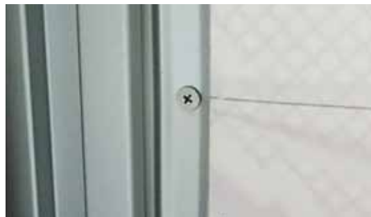
▲スバンドレル鉄骨下地留め
