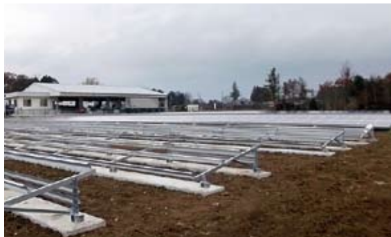
▲架台の固定に「タップスター」を納入
