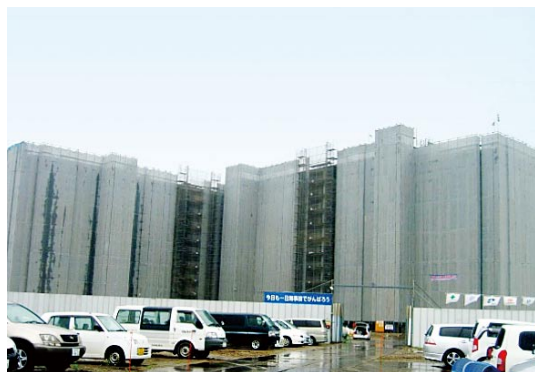
▲間仕切壁の固定にタップスターが採用されました
