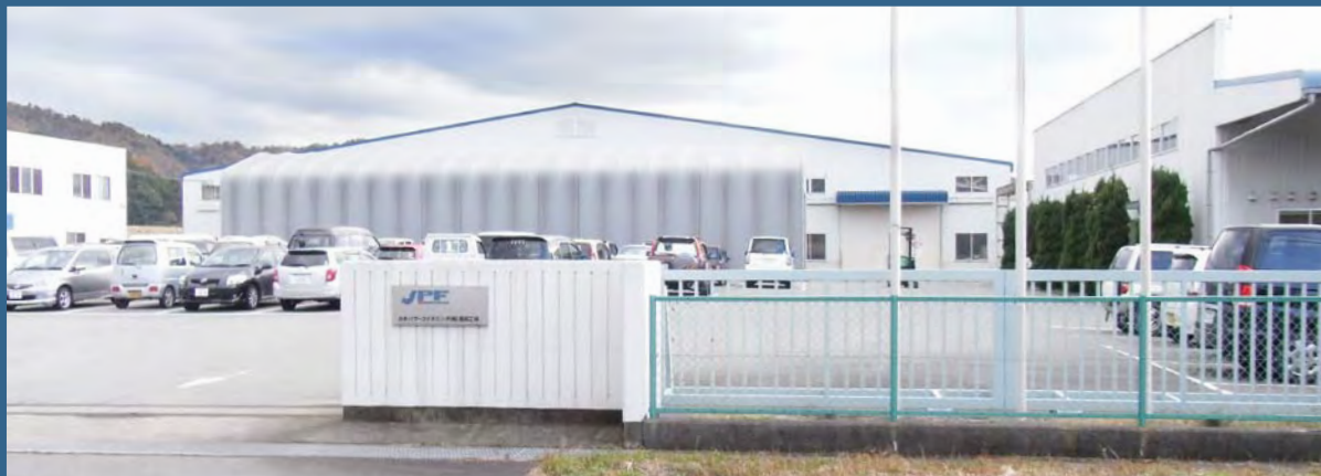
組立製造工場：当社豊岡工場
