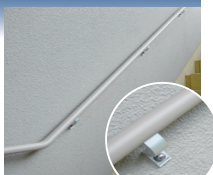
▲手すりの固定
